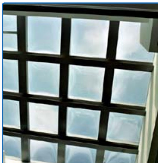
• Lucarnes alignées vue de l'intérieur
