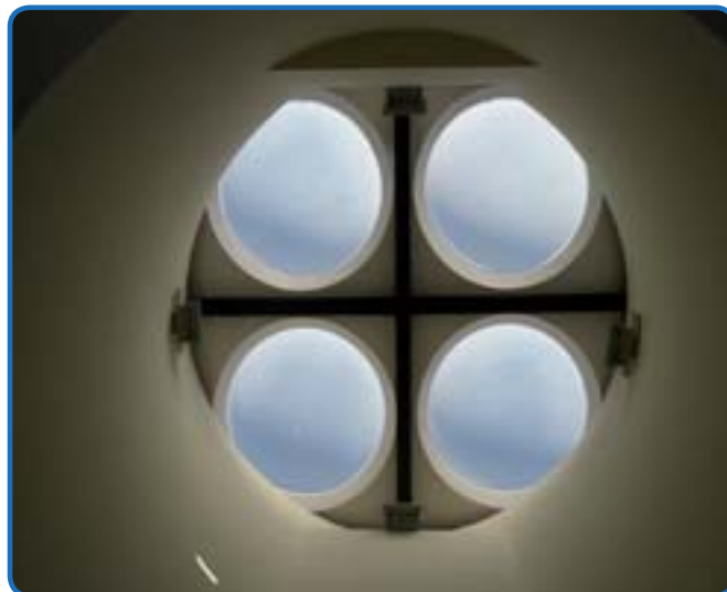
• Vue d'intérieur de la structure des lucarnes circulaires
