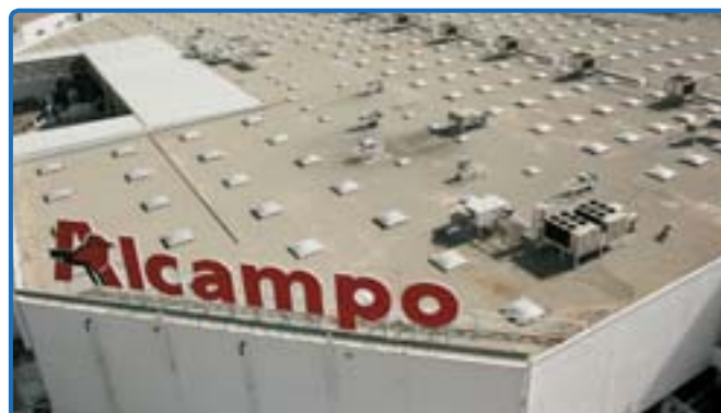
• Lucarne dans le centre commercial Alcampo
