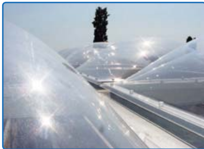
• Détail de la structure de l'extérieur
