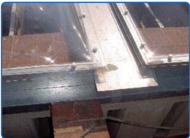
• Détail de la structure de l'intérieur
