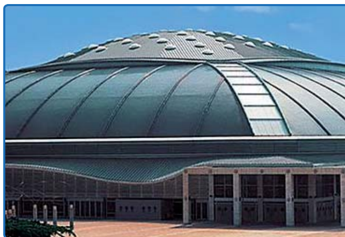
• Lucarnes dans un complexe sportif
